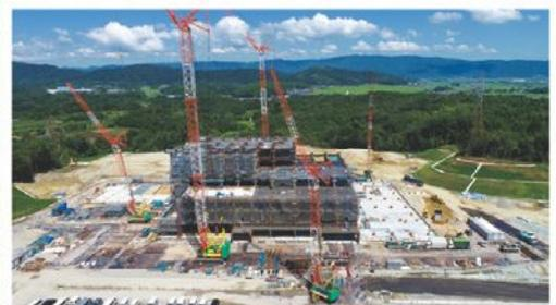
新病院建設進捗状況についてお知らせします。建物は5月に免震装置(免震構造では特徴の異なる数種類の免震装置を組み合わせ、それぞれの長所を活かす位置に設置することで、地震の揺れの大きな力を吸収しながら柔らかく抑え、建物を守ります。今回病院の地下に合計95個を設置しています。)の設置を終え、工事区画を3工区(西からA工区、B工区、C工区の順に)に分割して工事が進められ7月からは地上鉄骨建方が開始、10月には上棟予定となっております。
